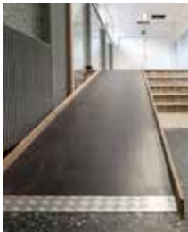
Stufenrampe zur Überwindung einer Treppe.
